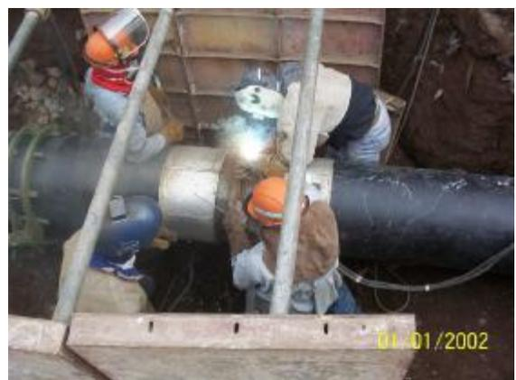
**Figura N° 05:** Proceso de soldadura de la red de gas.
